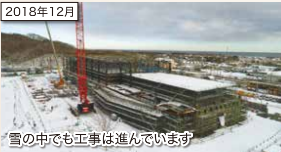
骨組みとなる鉄骨を建てます
