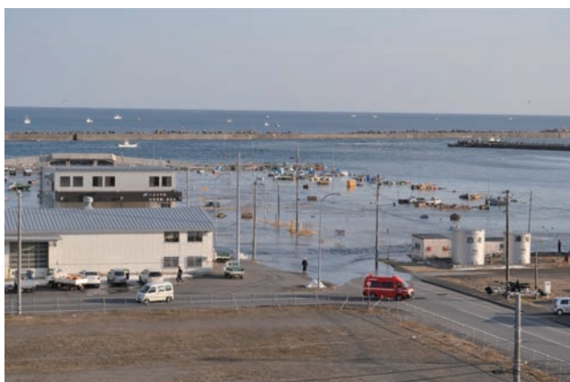
写真5 2011年東北地方太平洋沖地震による津波の被害を受けた白老港の様子（提供：白老町）
